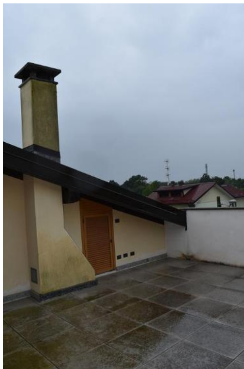
Foto 86: Lotto 1, abitazione, piano secondo (sottotetto)
