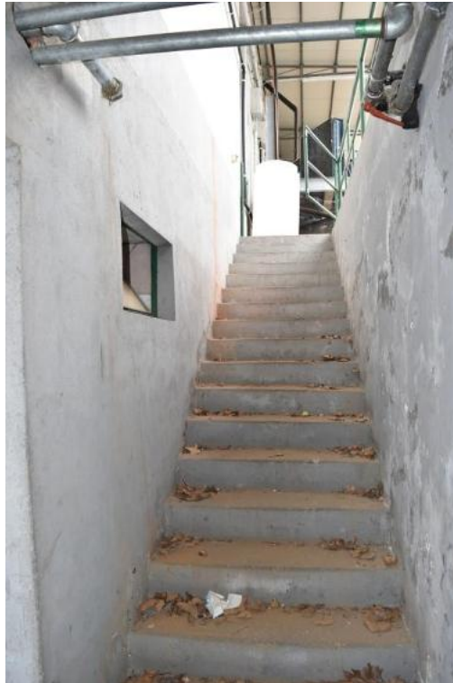
Foto 126: Lotto 2, magazzino (cantina), piano interrato
