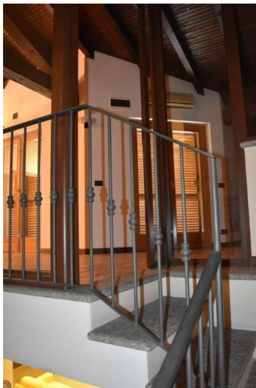
Foto 75: Lotto 1, abitazione, piano secondo (sottotetto)
