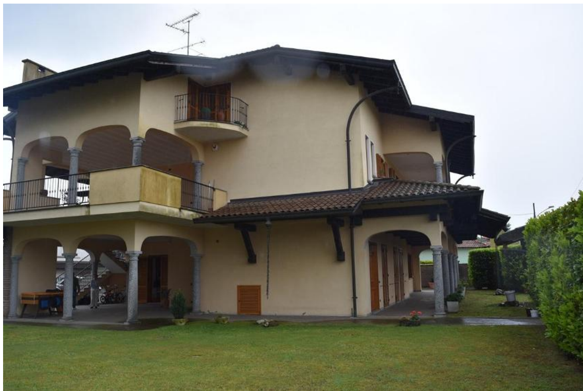
Foto 6: Lotto 1, abitazione, esterni
