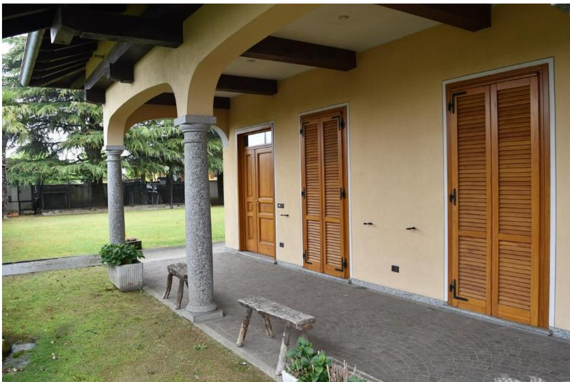
Foto 8: Lotto 1, abitazione, esterni
