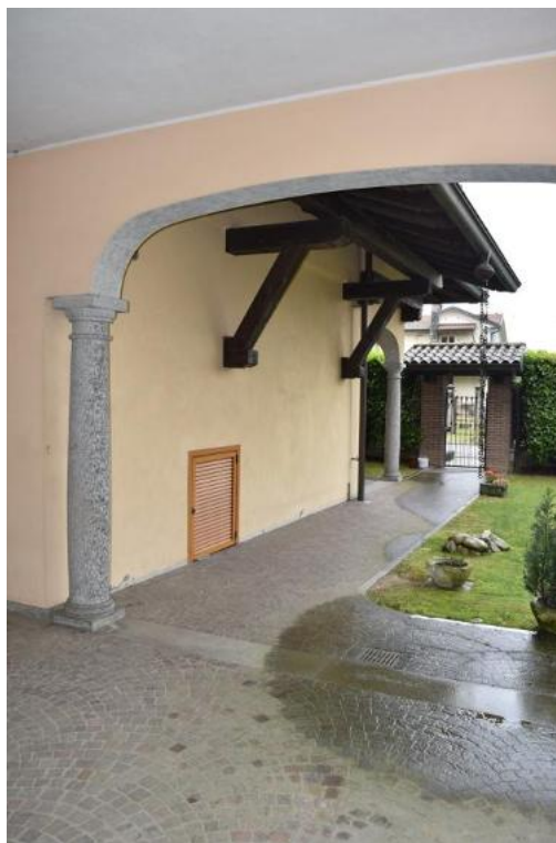
Foto 17: Lotto 1, abitazione, esterni
