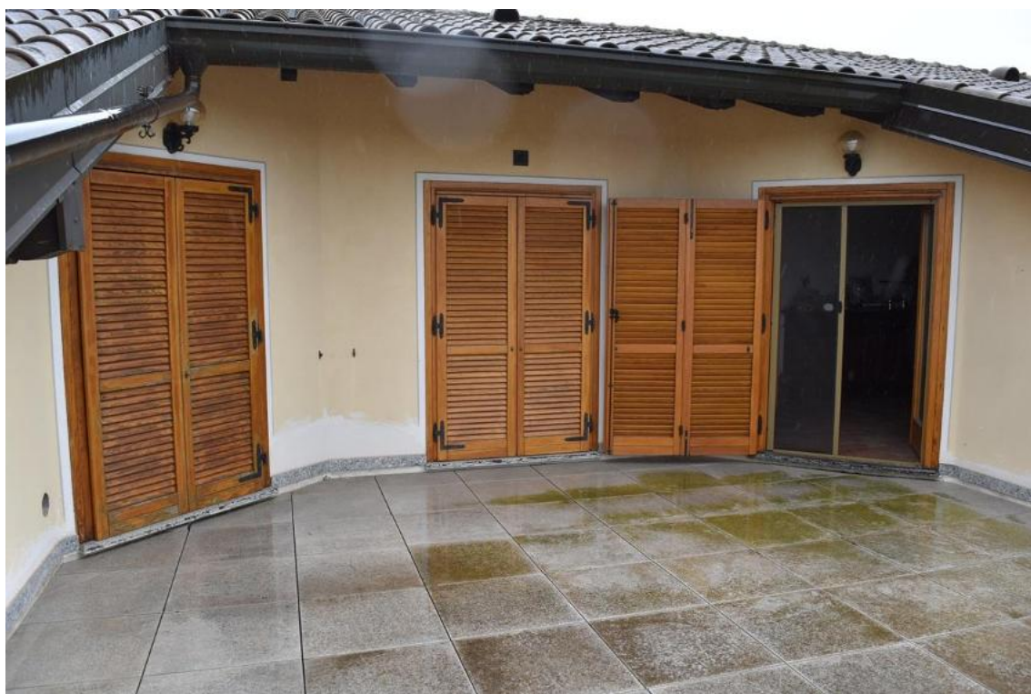
Foto 87: Lotto 1, abitazione, piano secondo (sottotetto)
