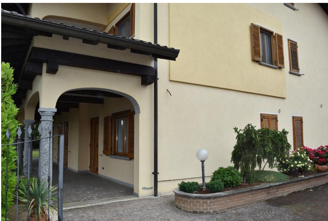
Foto 9: Lotto 1, abitazione, esterni
