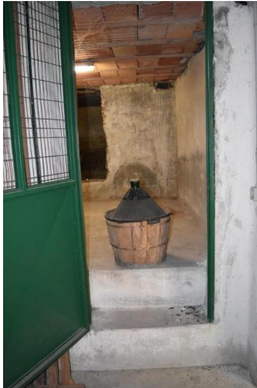
Foto 120: Lotto 2, magazzino (cantina), piano interrato
