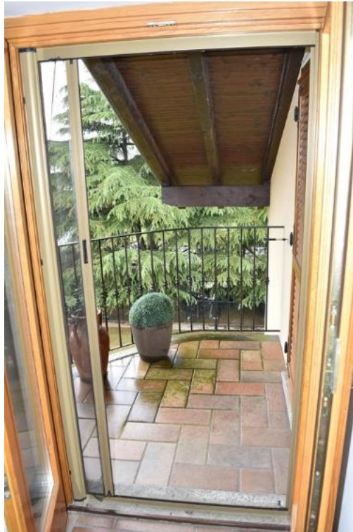
Foto 80: Lotto 1, abitazione, piano secondo (sottotetto)
