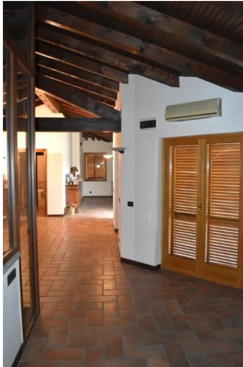
Foto 82: Lotto 1, abitazione, piano secondo (sottotetto)
