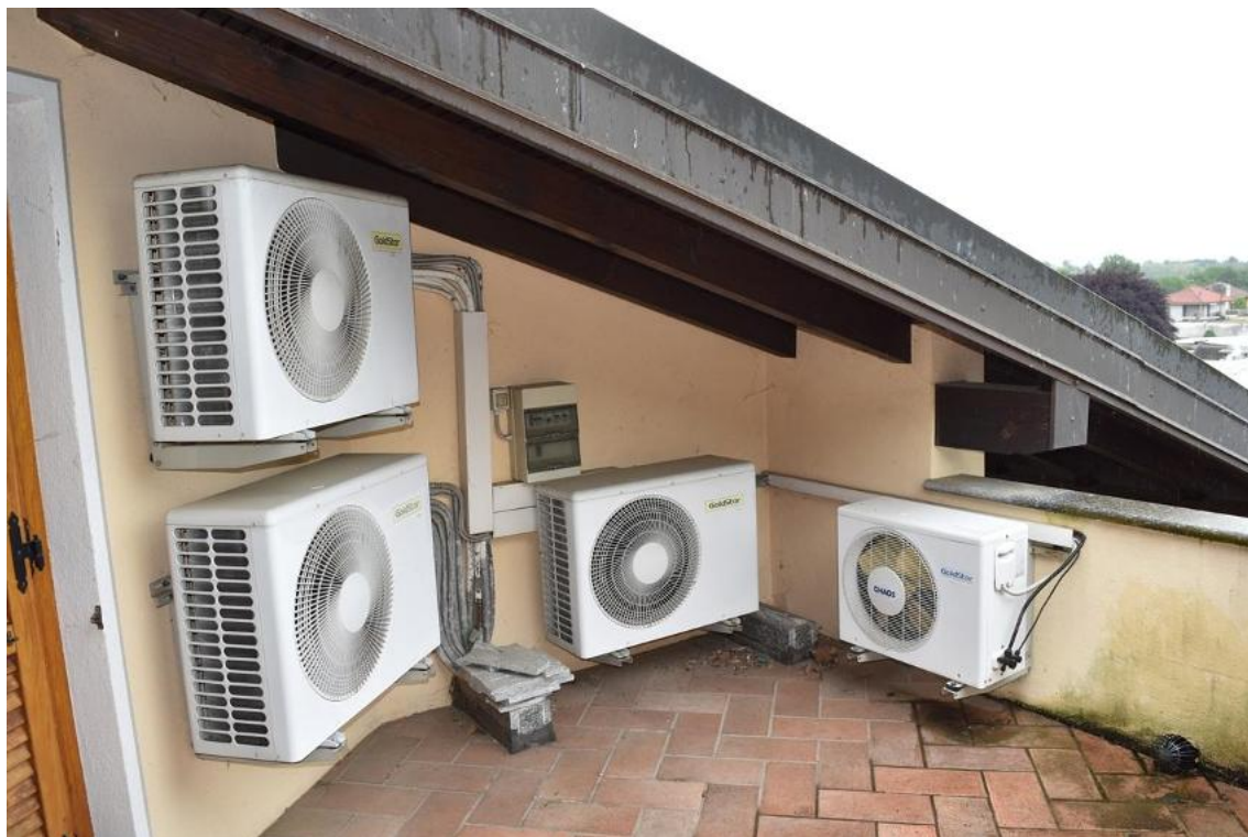
Foto 100: Lotto 1, abitazione, piano secondo (sottotetto)
