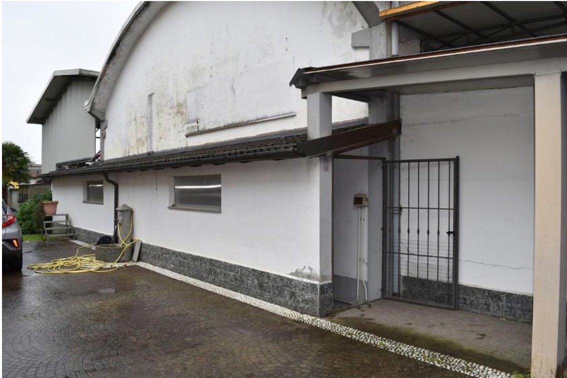
Foto 114: Lotto 2, magazzino (cantina), piano interrato
