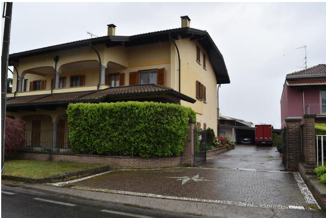
Foto 5: Lotto 1, abitazione, esterni
