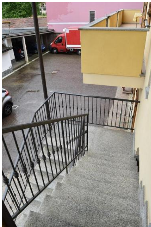
Foto 73: Lotto 1, abitazione, piano primo
