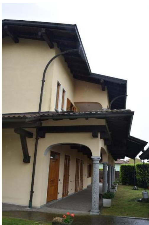
Foto 7: Lotto 1, abitazione, esterni
