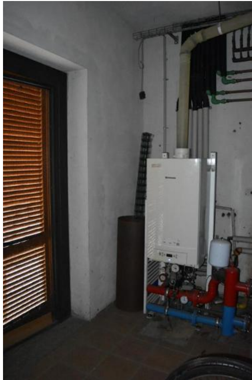
Foto 42: Lotto 1, abitazione, piano terra
