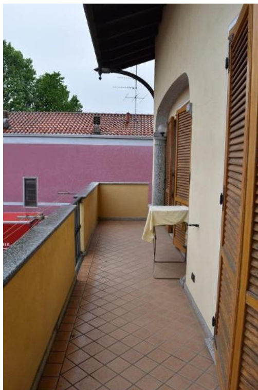
Foto 67: Lotto 1, abitazione, piano primo
