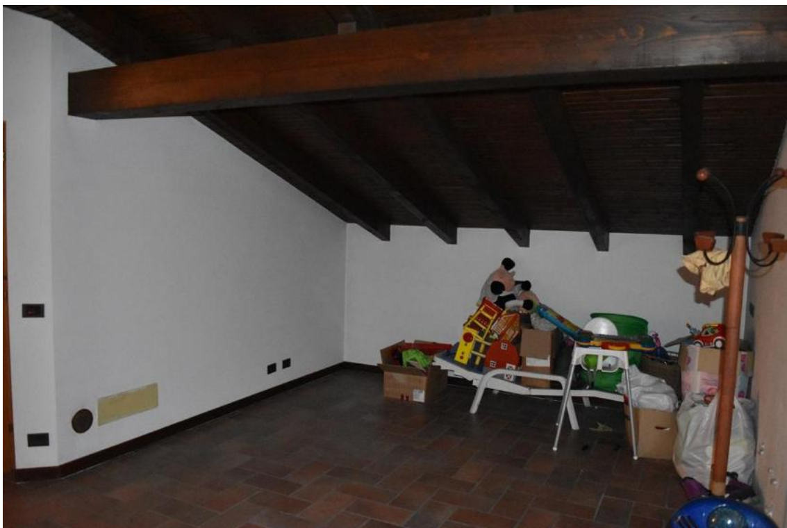
Foto 79: Lotto 1, abitazione, piano secondo (sottotetto)
