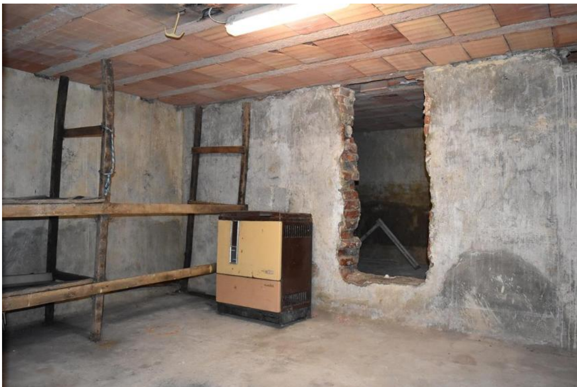
Foto 121: Lotto 2, magazzino (cantina), piano interrato
