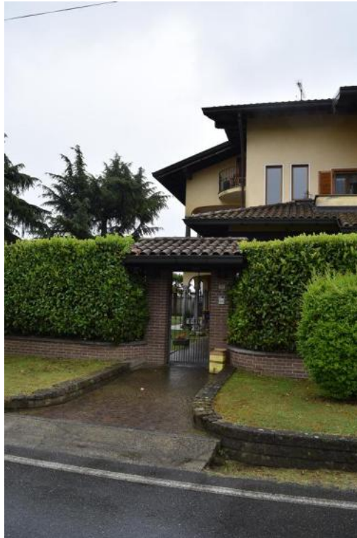
Foto 4: Lotto 1, abitazione, esterni
