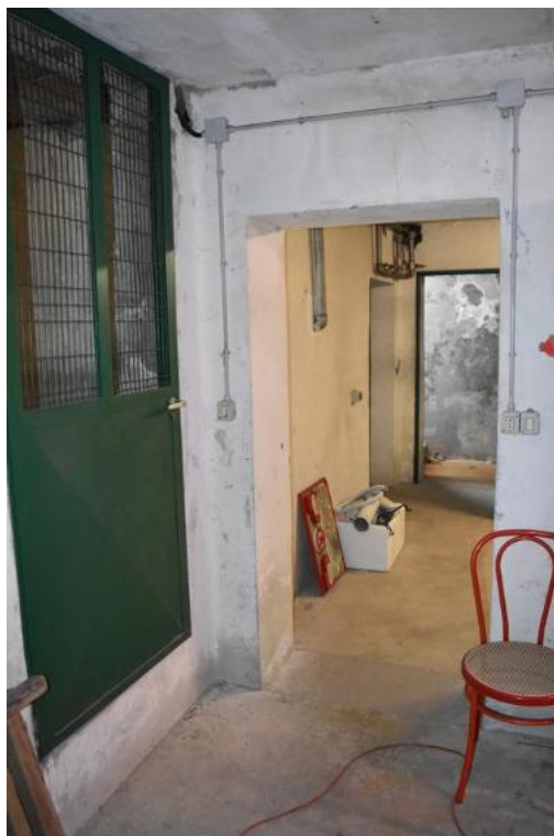
Foto 122: Lotto 2, magazzino (cantina), piano interrato
