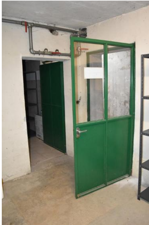
Foto 124: Lotto 2, magazzino (cantina), piano interrato
