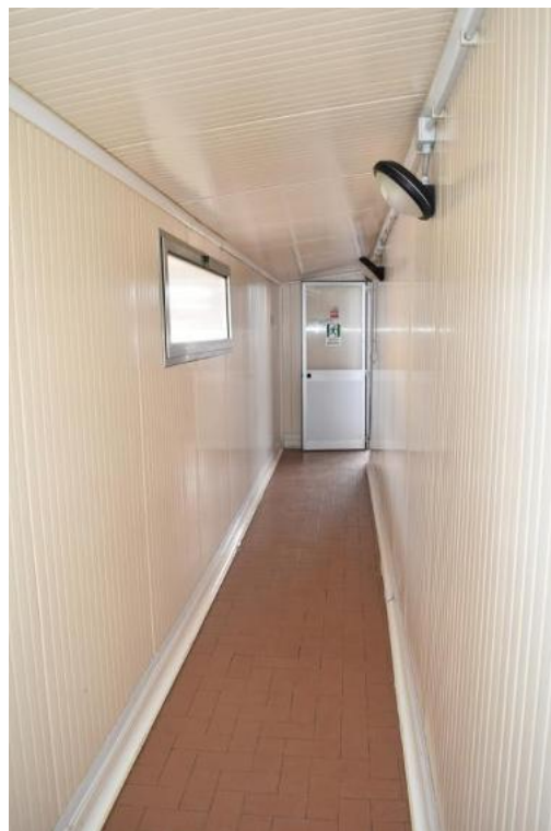
Foto 111: Lotto 2, magazzino (corridoio), piano terra
