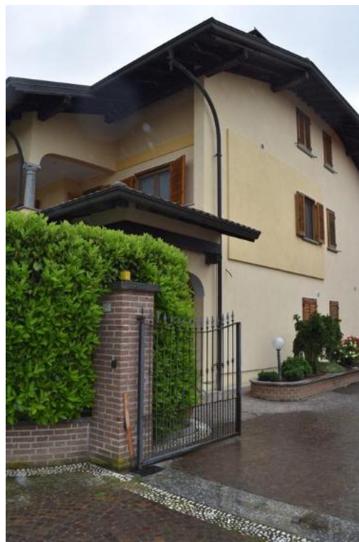
Foto 11: Lotto 1, abitazione, esterni
