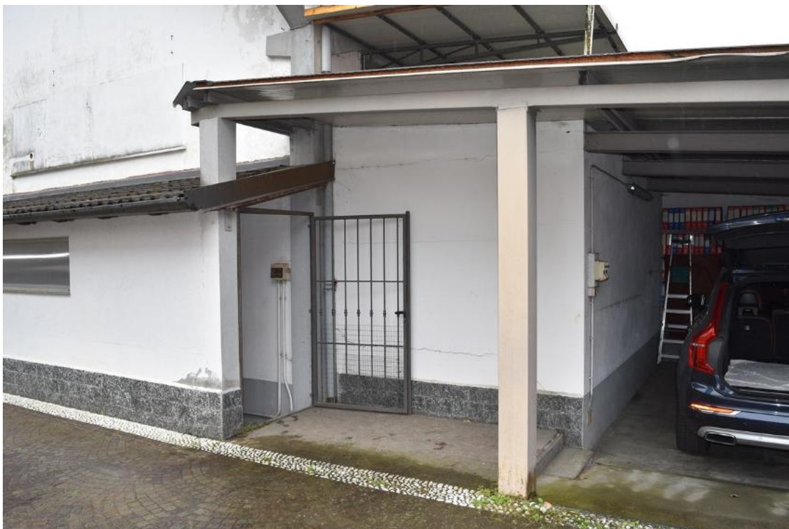
Foto 115: Lotto 2, magazzino (cantina), piano interrato
