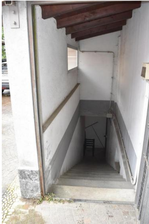
Foto 116: Lotto 2, magazzino (cantina), piano interrato
