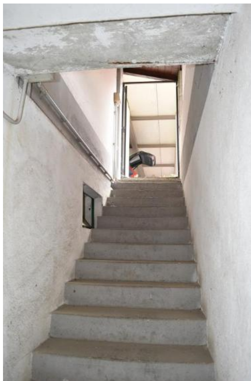
Foto 117: Lotto 2, magazzino (cantina), piano interrato
