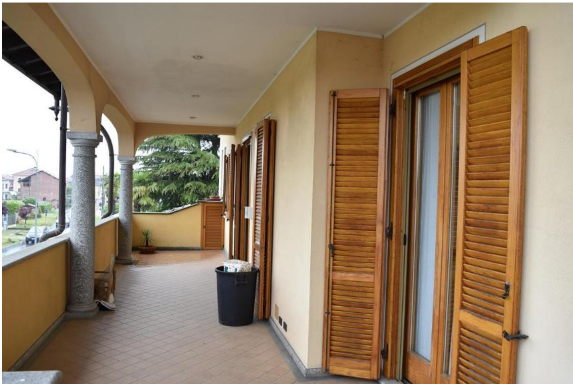
Foto 54: Lotto 1, abitazione, piano primo
