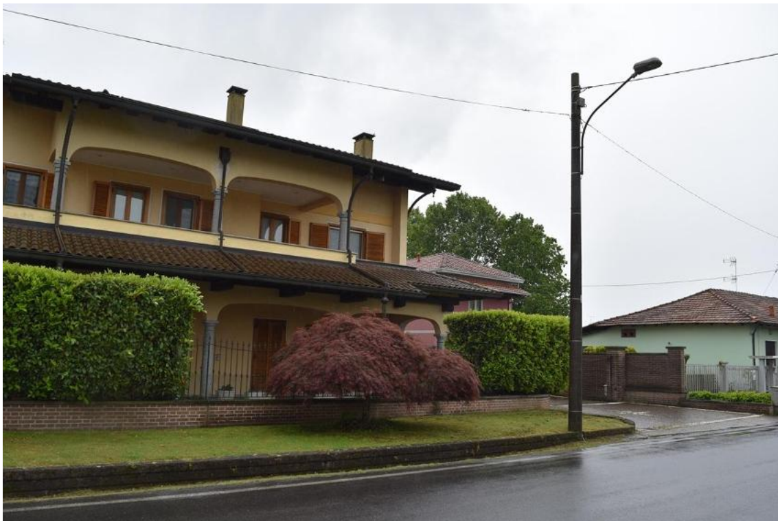
Foto 3: Lotto 1, abitazione, esterni
