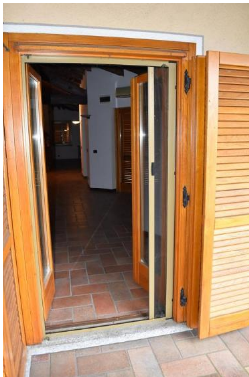
Foto 81: Lotto 1, abitazione, piano secondo (sottotetto)
