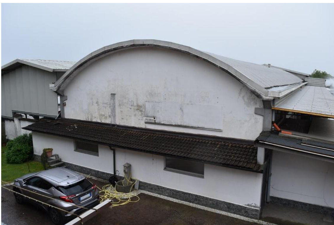
Foto 109: Lotto 2, magazzino (corridoio), piano terra
