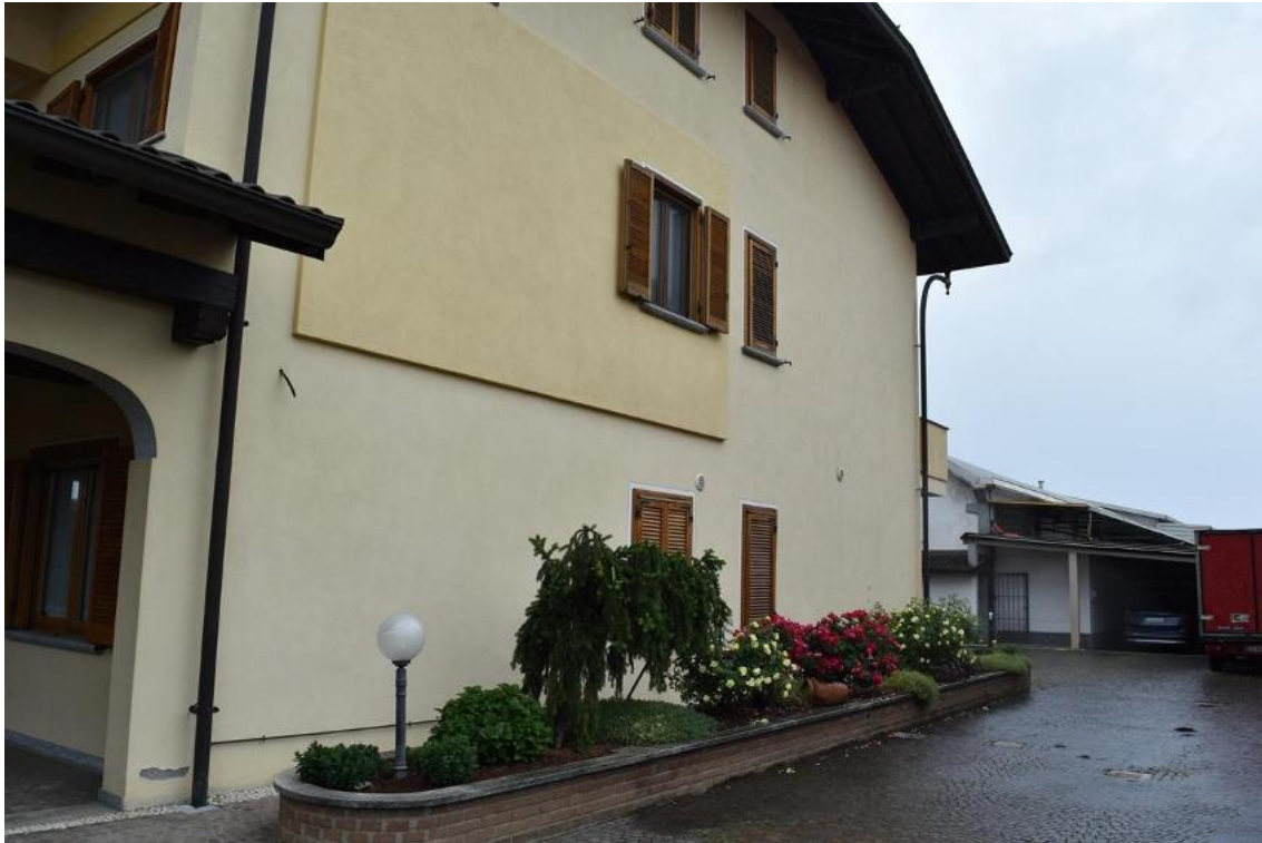
Foto 10: Lotto 1, abitazione, esterni
