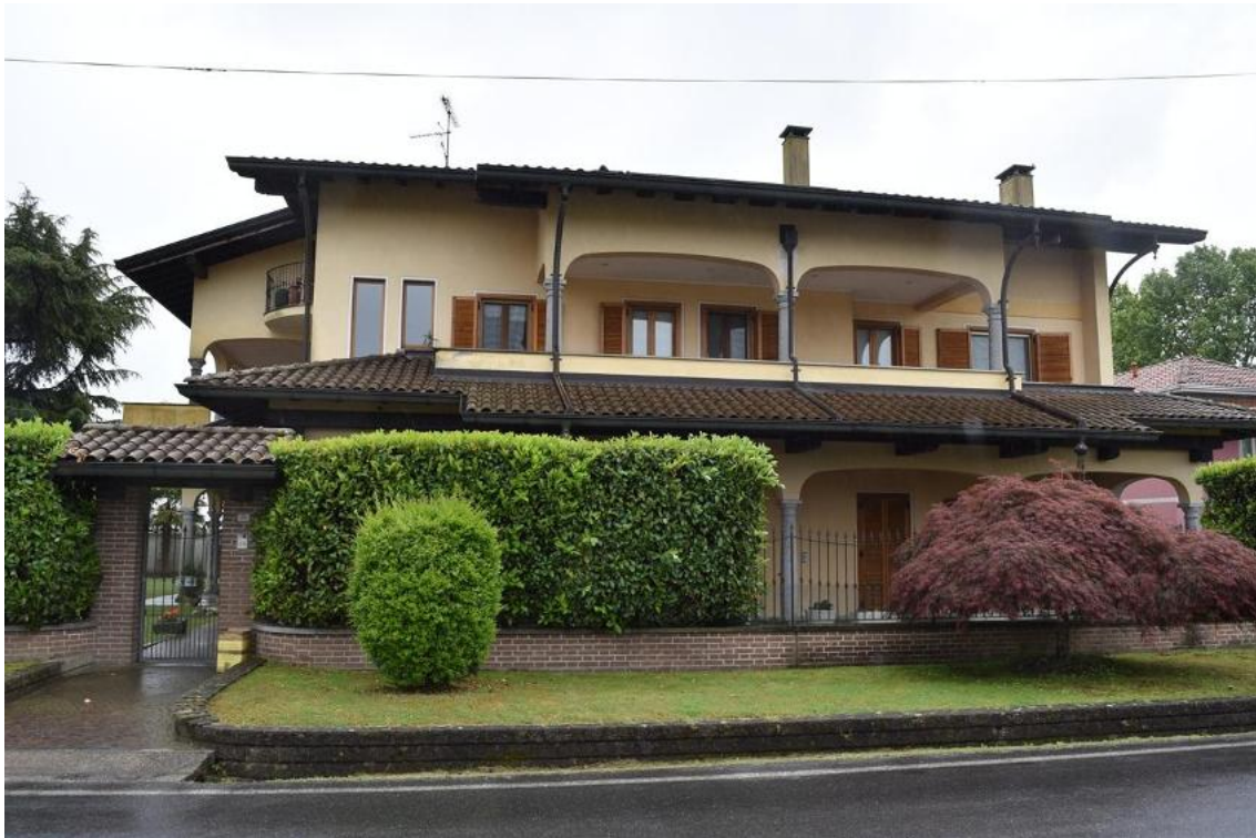
Foto 1: Lotto 1, abitazione, esterni
