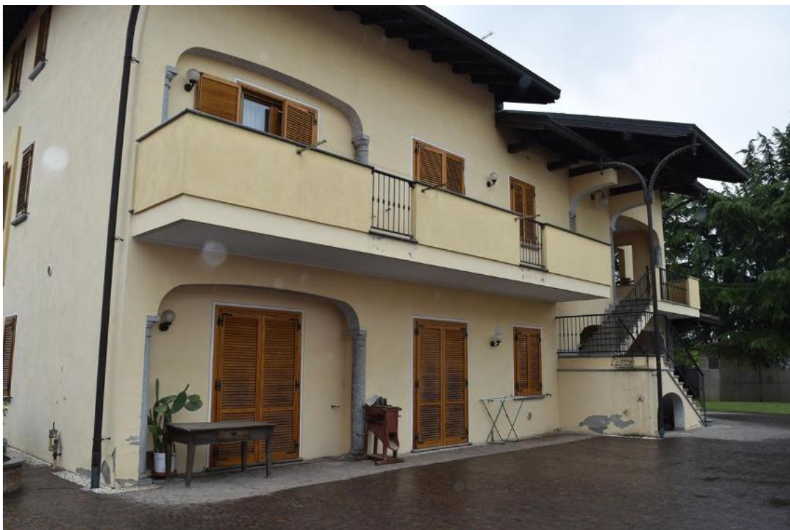
Foto 13: Lotto 1, abitazione, esterni
