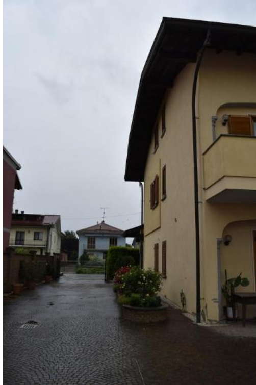
Foto 12: Lotto 1, abitazione, esterni
