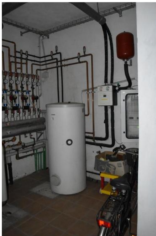
Foto 43: Lotto 1, abitazione, piano terra
