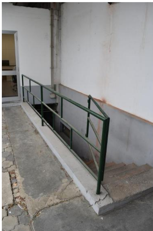
Foto 127: Lotto 2, magazzino (cantina), piano interrato
