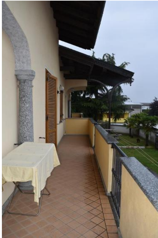
Foto 66: Lotto 1, abitazione, piano primo
