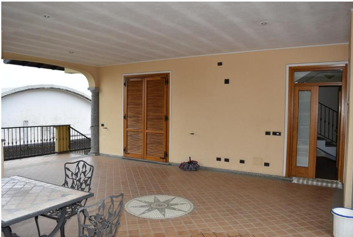
Foto 72: Lotto 1, abitazione, piano primo
